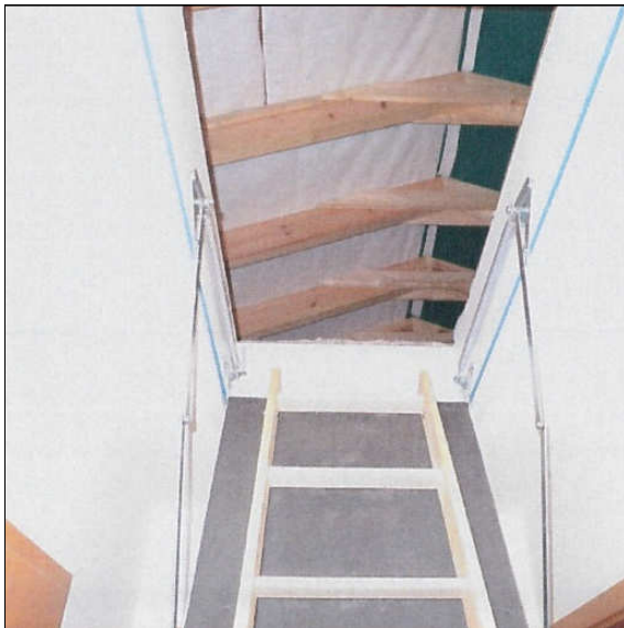
Abb. 52: Blick vom Flur im Obergeschoss in den Dachraum
