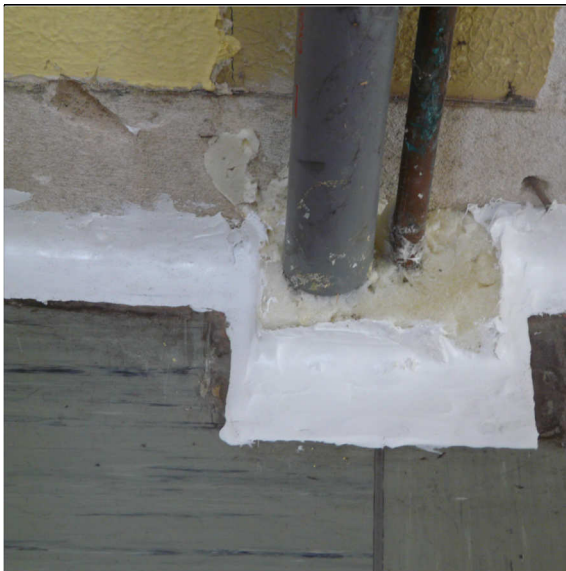
Abb. 15: Mit Dichtstoff verschlossene Randfuge des Fußbodens
