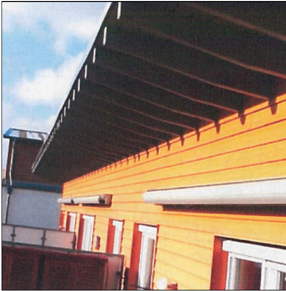
Abb. 32: Außenansicht des Staffelgeschosses
