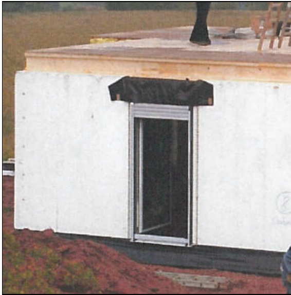
Abb. 24: Foto aus der Bauzeit zur ausgeführten Konstruktion
