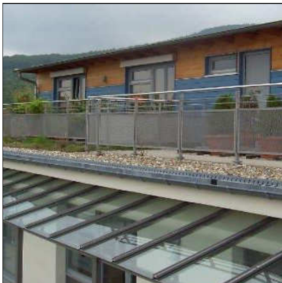
Abb. 20: Rückseitige Teilansicht des Staffelgeschosses
