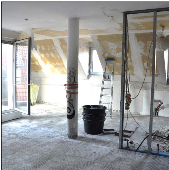
Abb. 36: Dachgeschoss während des Umbaus
