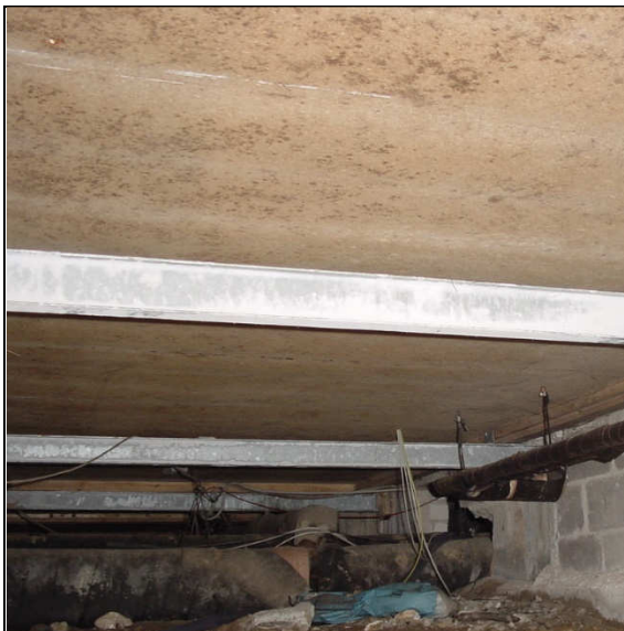
Abb. 9: Blick in den Kriechraum unter den Klassenzimmern
