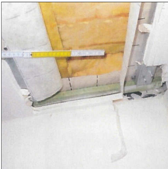
Abb. 34: Blick auf die geöffnete Bekleidung des Dachs
