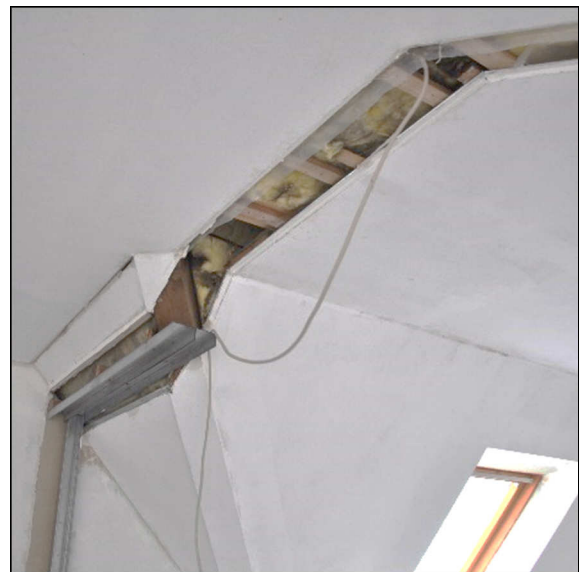
Abb. 41: Durch veränderte Grundrisse entstanden Lücken in der Luftdichtheitsebene, die geschlossen werden mussten.
