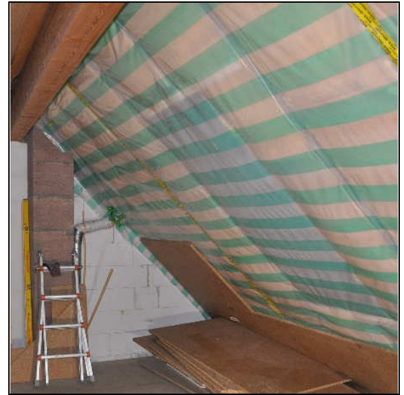
Abb. 43: Abschottung durch neu verlegte Luftdichtheitsfolie
