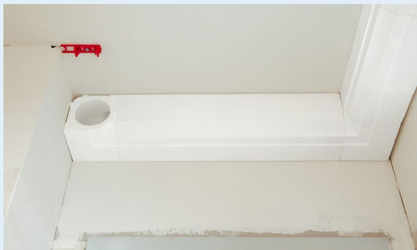
Abbildung 16: Kanalsystem in Stuckoptik für Sanierungen
