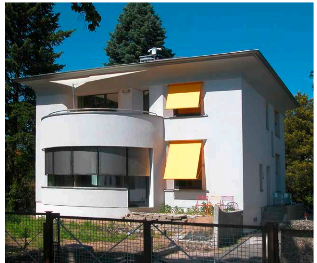
Bilder: Günther Ludwig (Solidar) Vorher-Nachher: Sanierung eines Einfamilienhauses aus den 1930er Jahren mit Außendämmung aus Zellulosefasern, Lüftungsanlage mit Wärmerückgewinnung, Holzpellet-Heizung. Schräge Fensterleibungen vermeiden den „Schießscharten-Effekt“ und wahren zusammen mit dem verlängerten Dachüberstand die ursprünglichen Proportionen des Hauses. Der Endenergiebedarf sank von 311 kWh/m 2 a auf 49 kWh/m 2 a.
